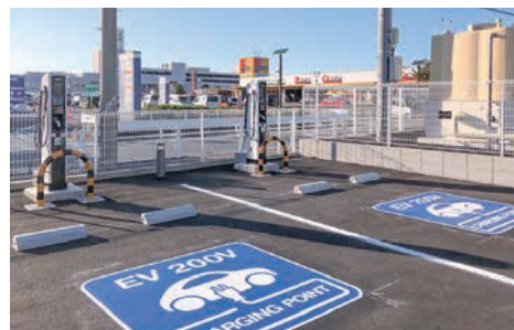
EV 充電器の設置
