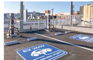
EV 充電器の設置
